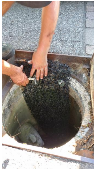
Befestigung des Geflechts mit zwei rostfreien Schrauben
