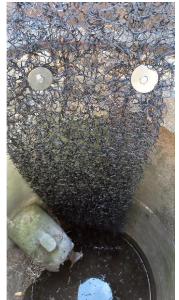
Die Ausstiegshilfe, stösst an den Tauchbogen und reicht ca. 10cm tief unter die Wasserlinie
